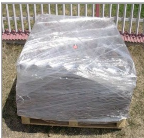
Przykład zabezpieczenia azbestu przed pyleniem
